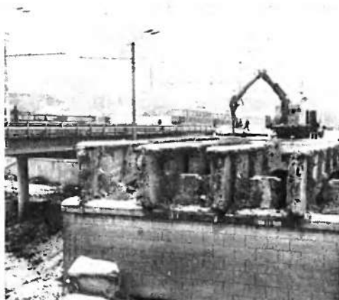
Разрушение взрывогенераторной установкой старого моста в г. Туле.
