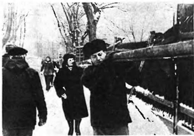
На снимках сверху (справа и слева) — москвичи на реставрационных работах памятника архитектуры XVIII века Крутицкое подворье.
